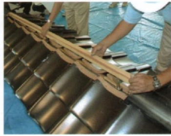
2. 受木取付 (棟金具高さ調整後)
