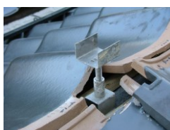
瓦を取り付けます
