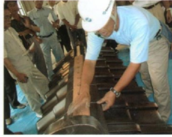
5. 鬼瓦仮付後、防災のし(大)取付
