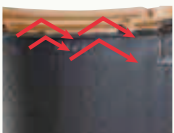
水返して雨水の逆流をシャットアウト。※写真はTSルーフ53B
